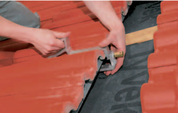
Nove krovne kuke za Solar 5000 TF i Solar 7000 TF - varijabilne i jednostavne
